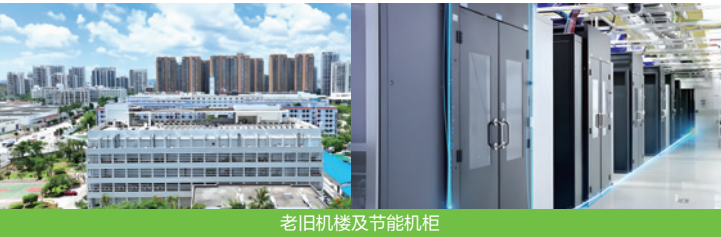
老旧机楼及节能机柜
